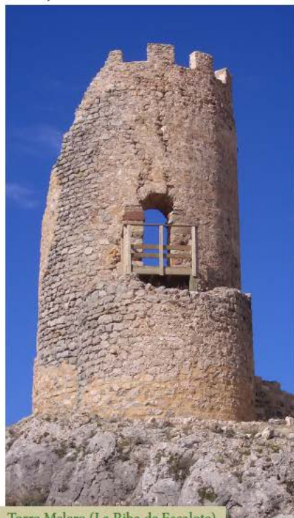
Torre Melero (La Riba de Escalote)
